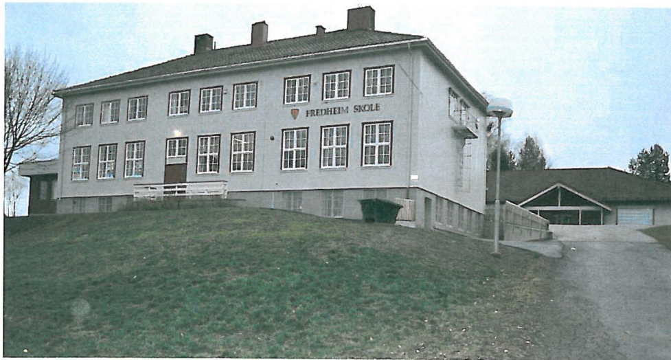
FREDHEIM SKOLE: Politikerne i Gran kommunestyre tok den nedslitte skolen i Tingelstad ut av tiltaksplanen. Men vinduene må skiftes uansett. Foto: Terje Nilsen.
