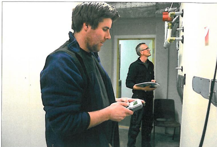
LUFTAR UT: Vaktmeistrane Narve Jordheim Brenna t.v. og John Johansen sjekkar ventilasjonsanlegget i kommunehuset i Hemsedal. Sjølv om anlegget er nytt, meiner dei det er mykje å spare på betre styring. - Anlegget treng ikkje gå for fullt viss det er eit møte med få personar, seier dei.
